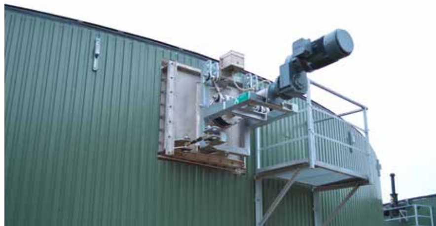
Außenständer-Wand-Konstruktion zum Einsatz in einem Stahlbehälter. Zur technischen Klärung ist vorab ein Fachgespräch notwendig.
