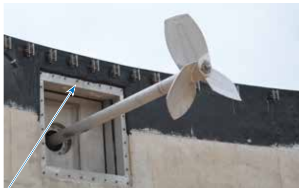
Coffrage béton pour un montage plus facile
